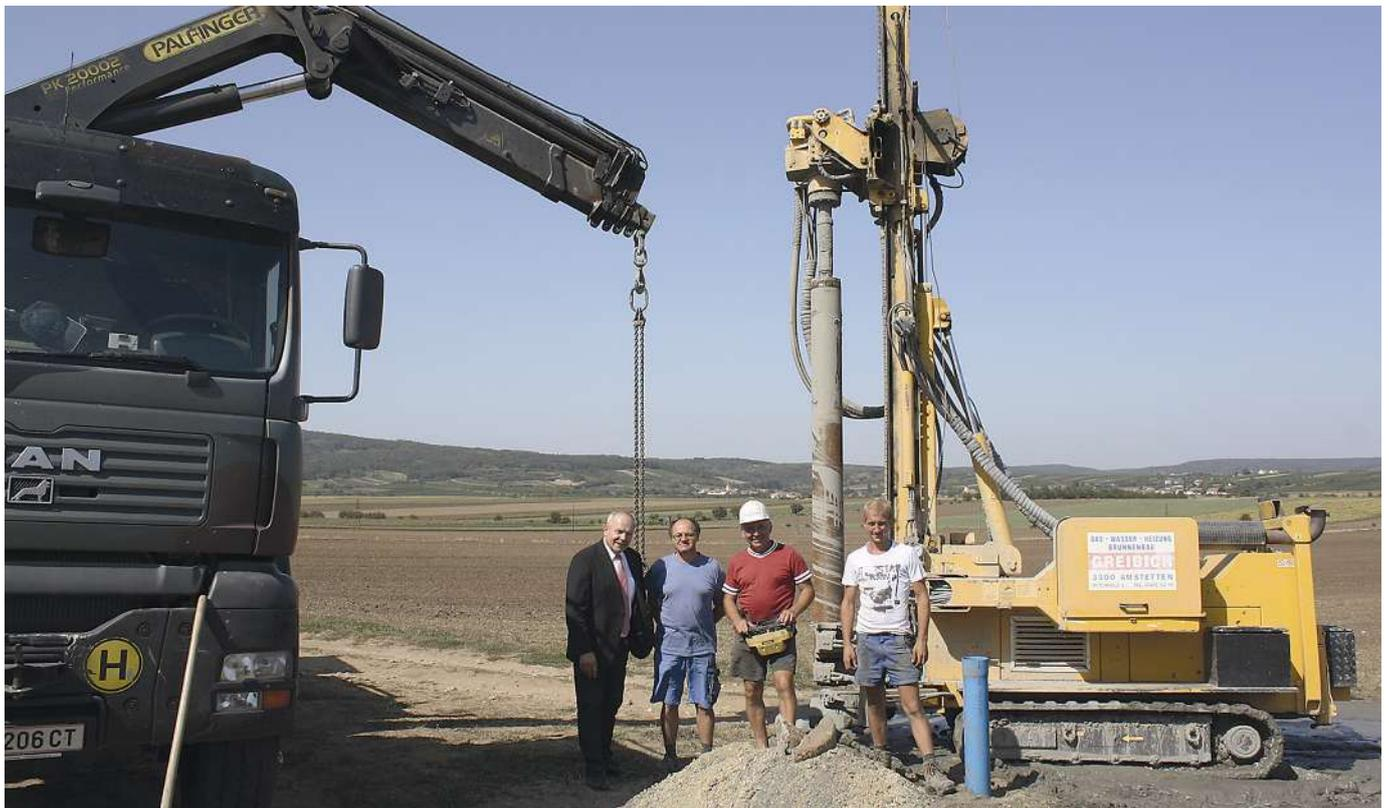
Die letzten Untersuchungen bevor es mit dem Bau eines neuen Brunnens losgehen kann, wurden begonnen. Es werden an mehreren ausgewählten Bereichen Grundwassermessstellen eingerichtet, die Aufschluss über etwaige Veränderungen beim Zustrom zum neuen Brunnen geben sollen. Weitere Analysen und Pumpversuche werden durchgeführt. Sollten die Ergebnisse den Erwartungen entsprechen, könnte nach dem wasserrechtlichen Verfahren 2018 mit dem Bau eines neuen Brunnens begonnen werden.
